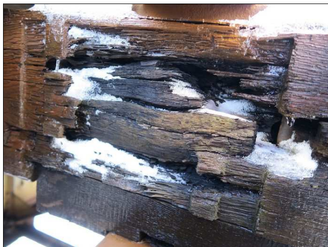
Foto č. 5 – K 01, nahnílá mostnice č. 15 v místě dřívějších podkladnic.
