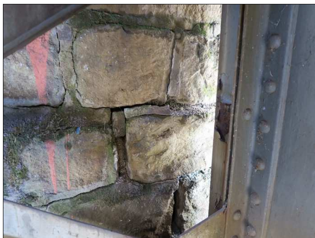
Foto č. 3 – O 01, hloubkově vypadané spárování a rozvolnění zdiva závěrné zdi vlevo.
