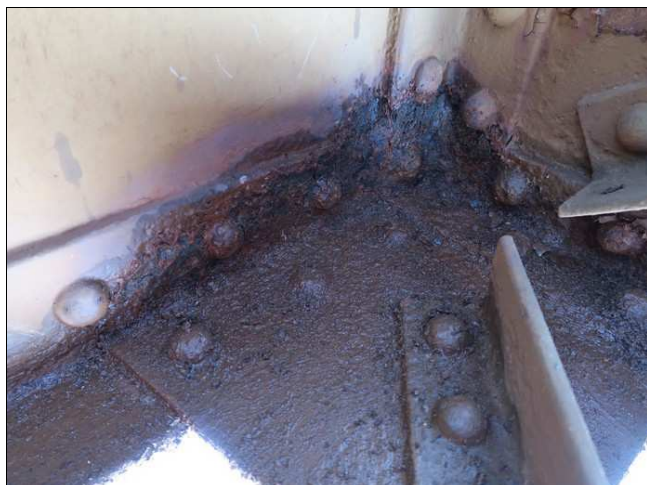
Foto č. 1 – K 01, zkorodovaný dolní krční úhelník za 7. příčným ztužením vpravo.
