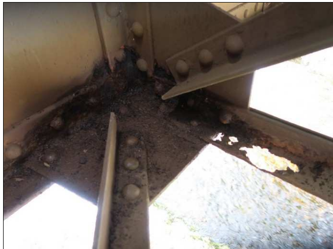
Foto č. 2 – K 01, zkorodovaný dolní úhelník 2. příčného ztužení vlevo.
