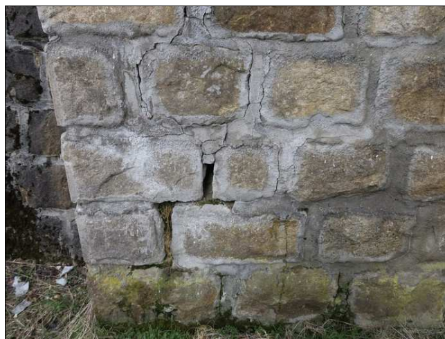
Foto č. 4 – O 02, popraskané a hloubkově vypadané spárování v levé dolní části opěry.
